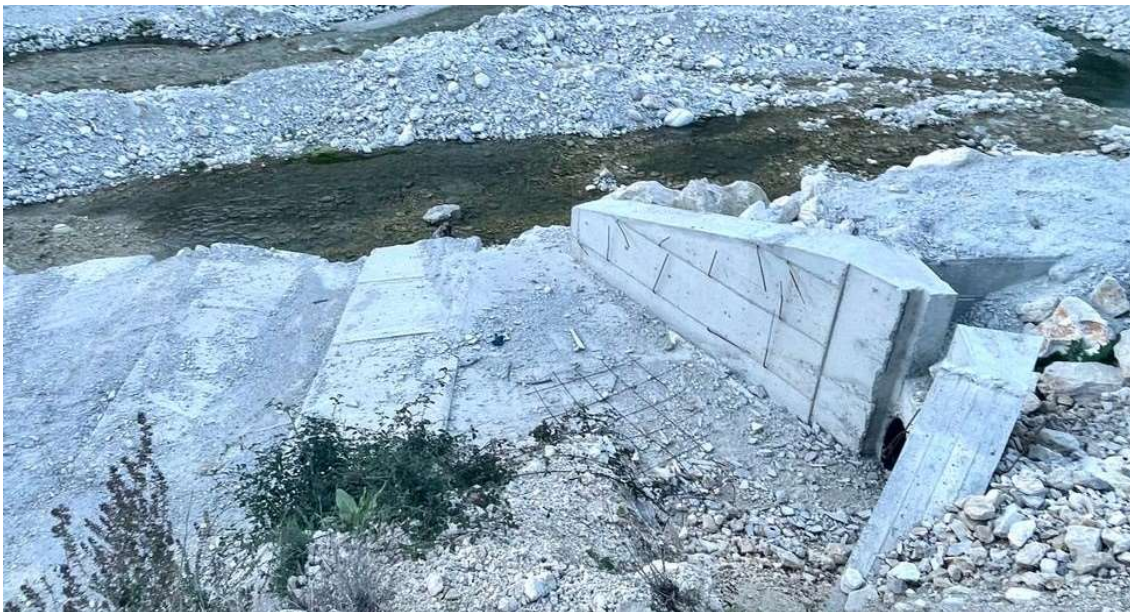
Figura 21: Ndërtimi i një kanali të ri ujitës në degën Kardhiq (Figura: Riverwatch/Ulrich Eichelmann)
